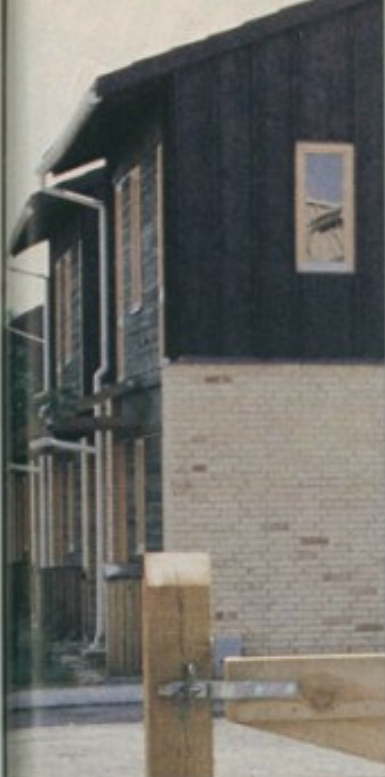
Gavlene er muret i gule tegl forneden og har træ foroven.
